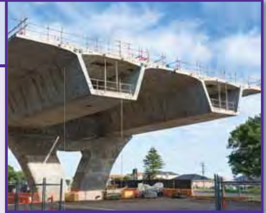
Los ingenieros civiles estudian las fuerzas que ejercen sobre este puente los autos en movimiento.
